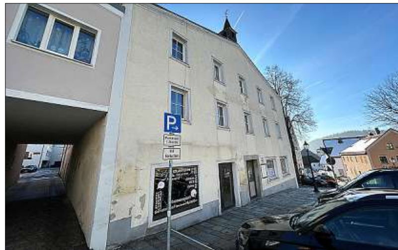
Wie man's kennt: das Haus von außen. Die Fassade wird sich ändern.
