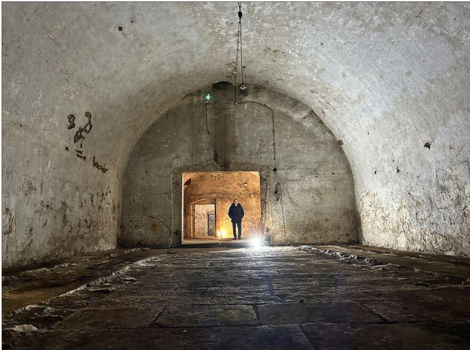
Hier gibt's bald Kunst und Klang: Der riesige Gewölbekeller unter dem „Passauer Hof“.
